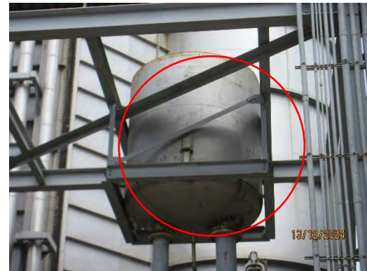
ภาพที่ 2-11 ตัวอย่างภาพถ่ายไซเลนเซอร์ (Silencer)
