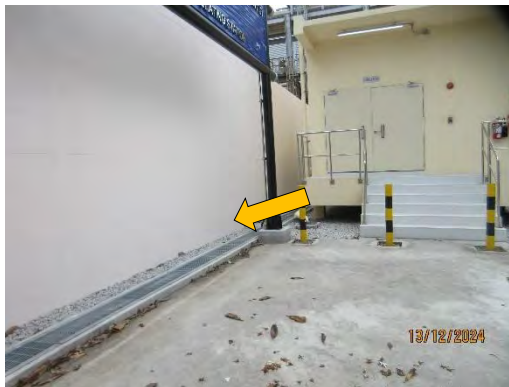
ภาพที่ 2-24 ตัวอย่างภาพถ่าย Firewall บริเวณหม้อแปลงไฟฟ้าและ MRS
