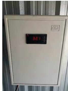
ภาพที่ 2-6 ตัวอย่างภาพถ่ายเครื่องตรวจวัดอุณหภูมิและความเข้มข้นคลอรีนแบบอัตโนมัติของน้ำทิ้ง จากรางระบายน้ำทิ้งของโครงการ
